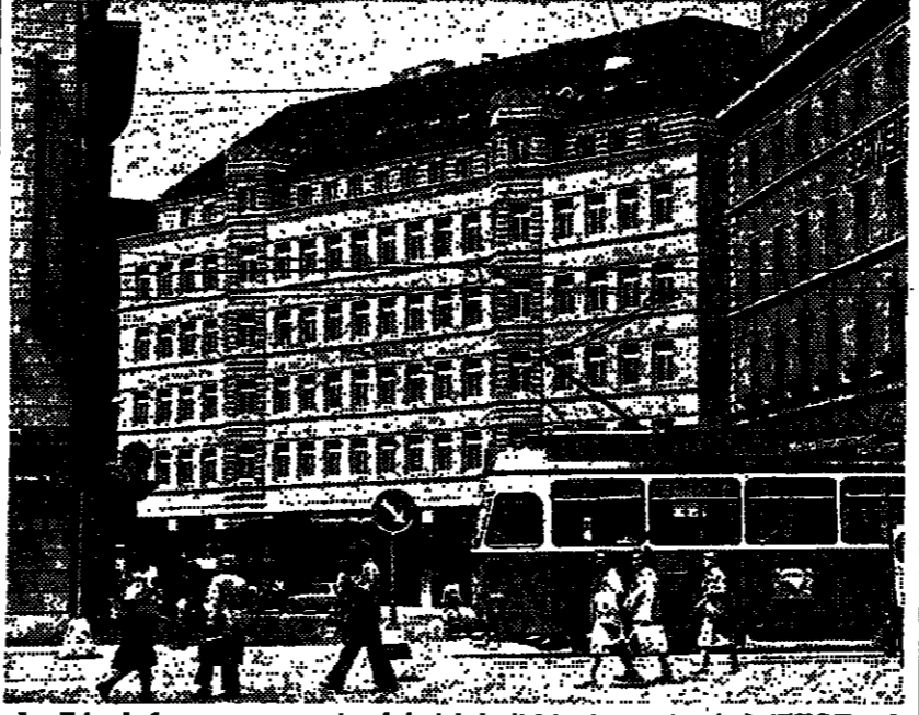
Le «Felsenhof» - nouveau quartier général de la division internationale de l'UBS Zurich
